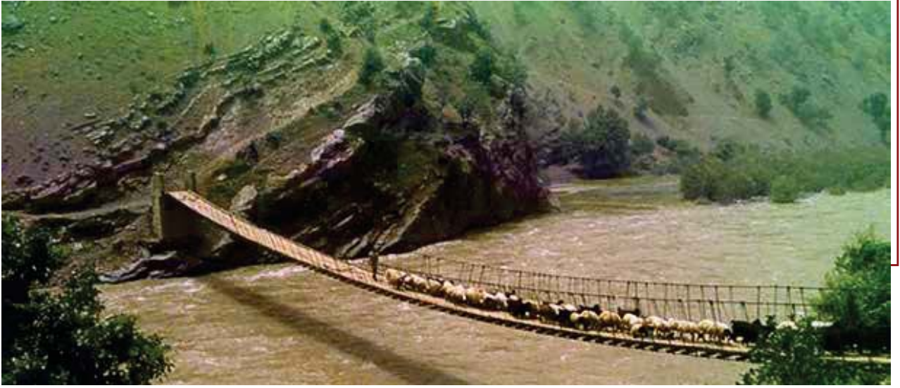
Deştan Köprüsü, Biyadır çobanlarına da yaramıştı.
